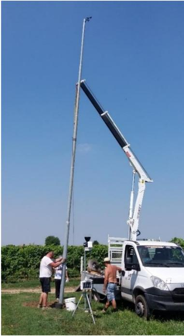
Fig. 7a Operazione di posa del palo anemometrico.
